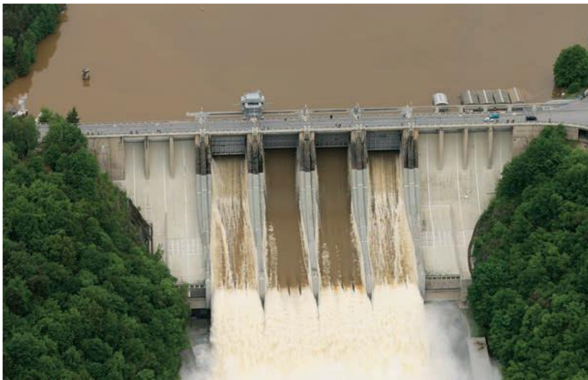
Obrázek 1: Vodní dílo Slapy – přepouštění bezpečnostními přelivy při povodni (převzato z Výroční zprávy 2023 Povodí Vltavy, s.p.)
