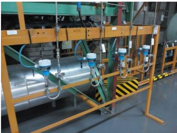
Snímače tlaku na stendu strojovny
